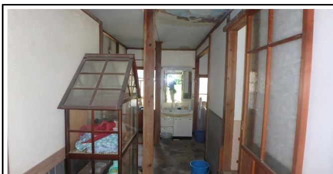
▲1階 洗面台とトイレに続く土間
